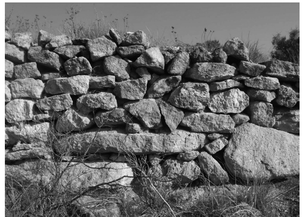
Figura 11: Detalle de la mampostería irregular con disposición intencionada de grandes bloques en las partes más bajas.
