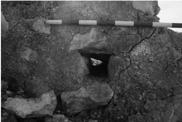
Figura 17: Detalle de los desagües del Castillete.
