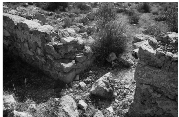
Figura 16: Vista parcial de uno de los vanos del Castillete.
