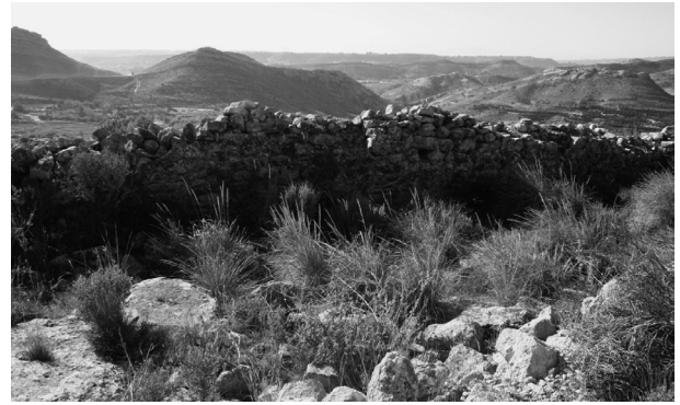
Figura 10: Vista de la muralla
