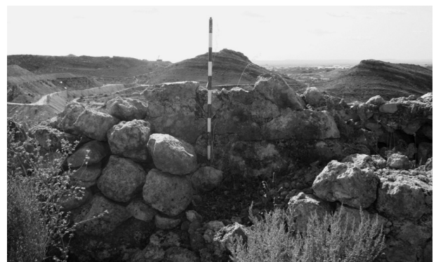
Figura 12: Detalle del adarve de la muralla Sur.
